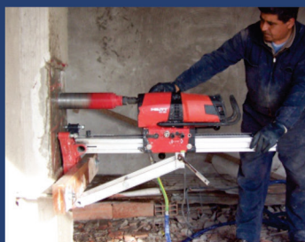
Equipo extractor de testigos con broca diamantada
